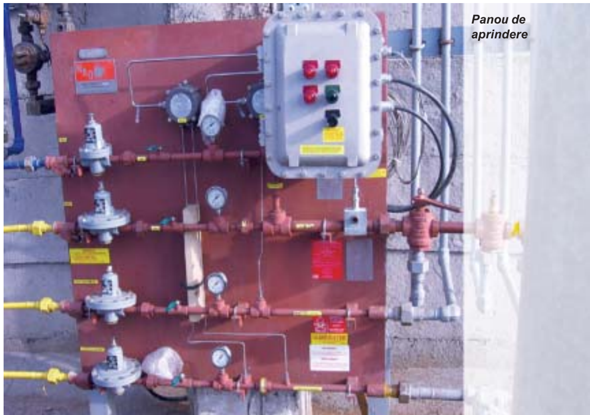
Baza capului de faclă cu racordurile necesare
